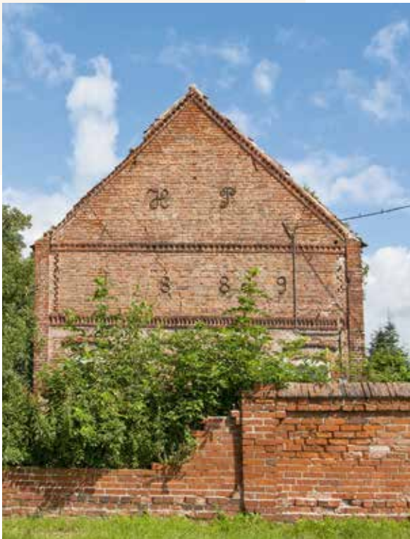
Solide Bauweise gegen das zuweilen raue Wetter der Uckermark.
